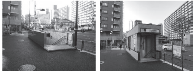
駅出入口浸水防止対策（対策前後）
