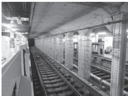
トンネル中柱耐震補強
