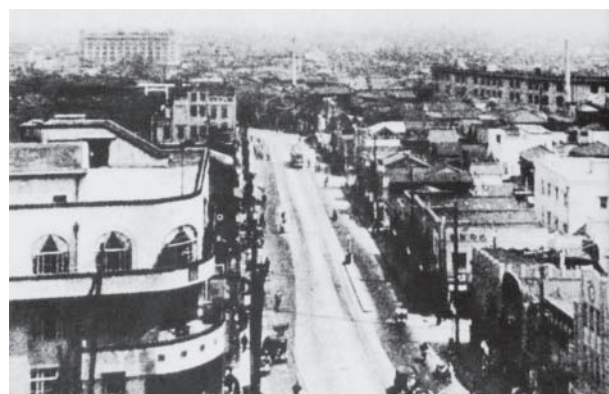
▲本郷区役所から上野松坂屋方面を望む町並み。右側の3階建ての横長の建物は湯島小学校(1936年(昭和11)ころ) (『本富士警察100周年記念アルバムより』)
