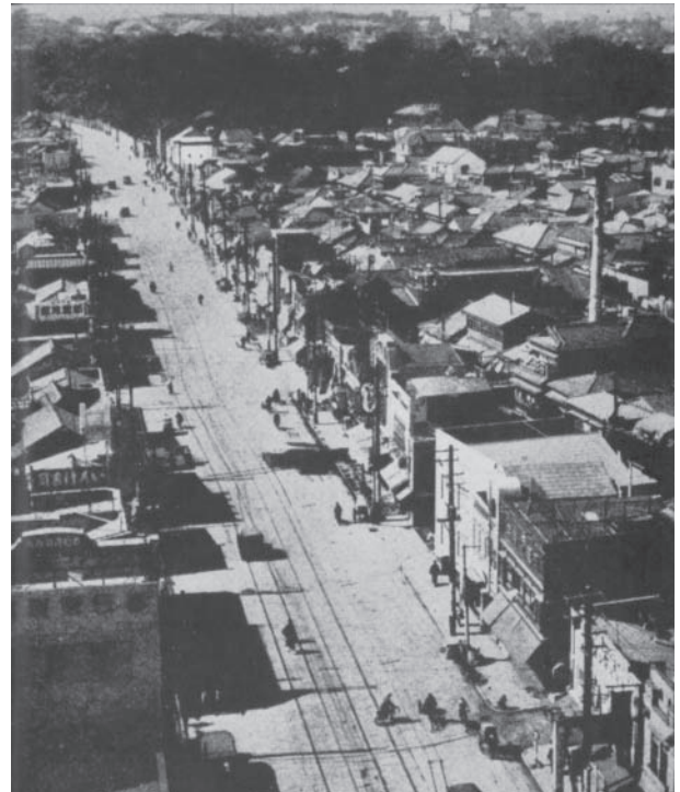
▲上野松坂屋の屋上から湯島方面を望む町並み。中央を走っている電車通りは現在の春日通り。右手に玉の湯の煙突が見える。現・ホテルパインヒルのあたり<昭和初期> 提供:文京ふるさと歴史館
